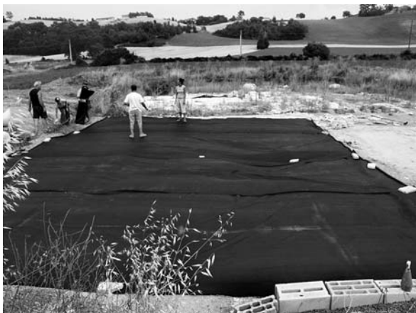
Fig. 7. L'operazione di interrimento dell'intero edificio 4.
